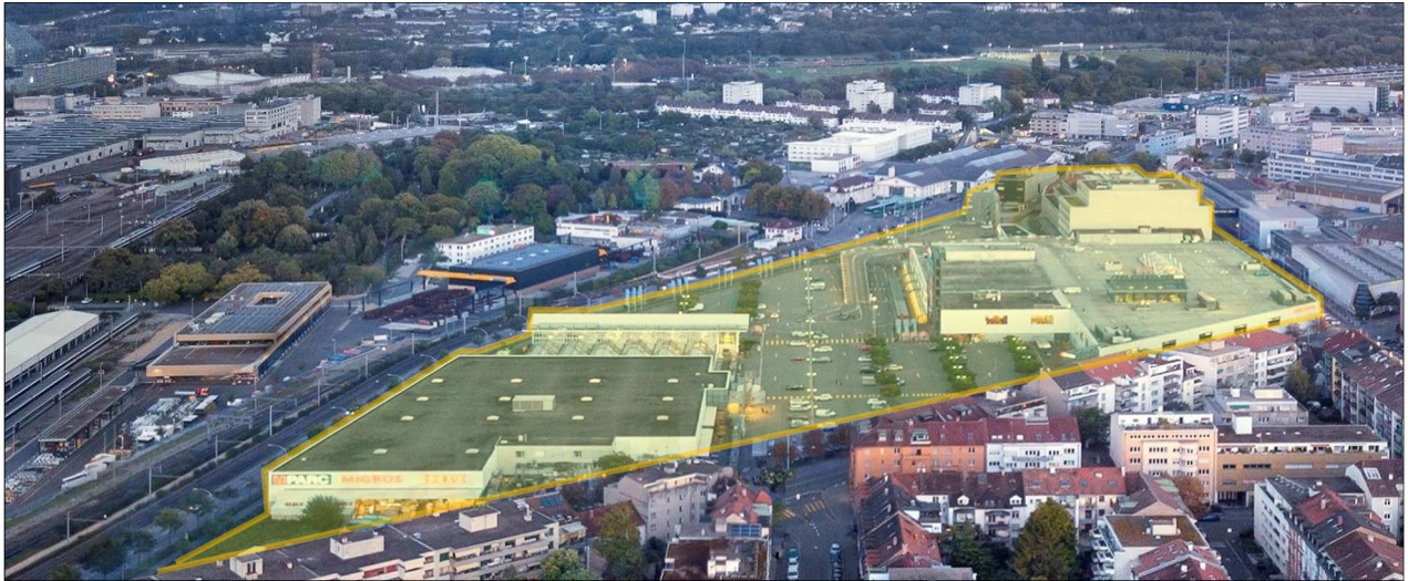
Abb. 1: Areal Dreispitz Nord. Luftbild. Quelle: Herzog & de Meuron, 2018
